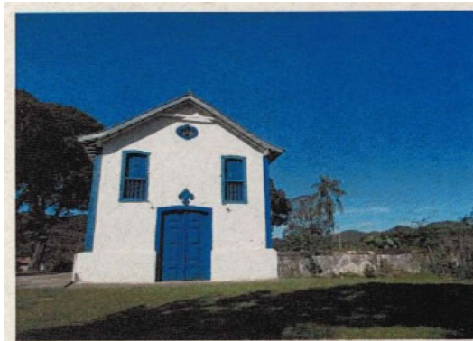
Capela de São Bento antes do rompimento da barragem de Fundão.
