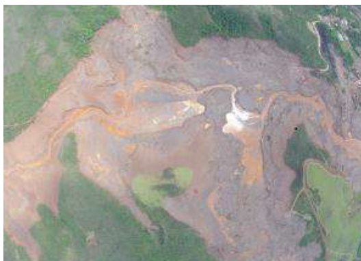
Córrego Santarém após ruptura da barragem. Foto: SISCOM/IBAMA.
